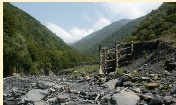
Разрушенная селезащитная плотина на реке Дурджи выше города Кварели
