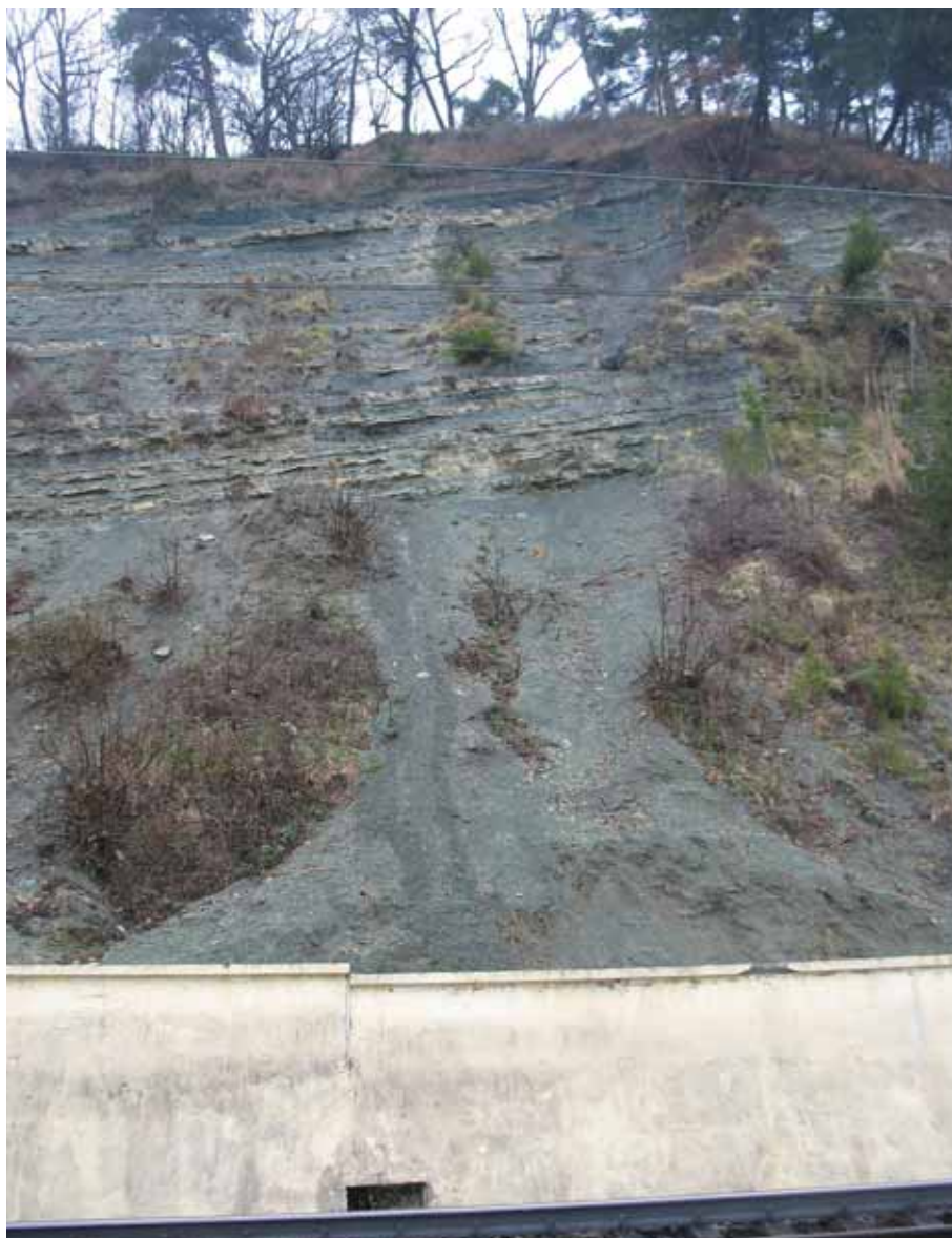
Рис. 4. Склоновый микросель на обвально-оползневом склоне на участке железной дороги Туапсе — Адлер
