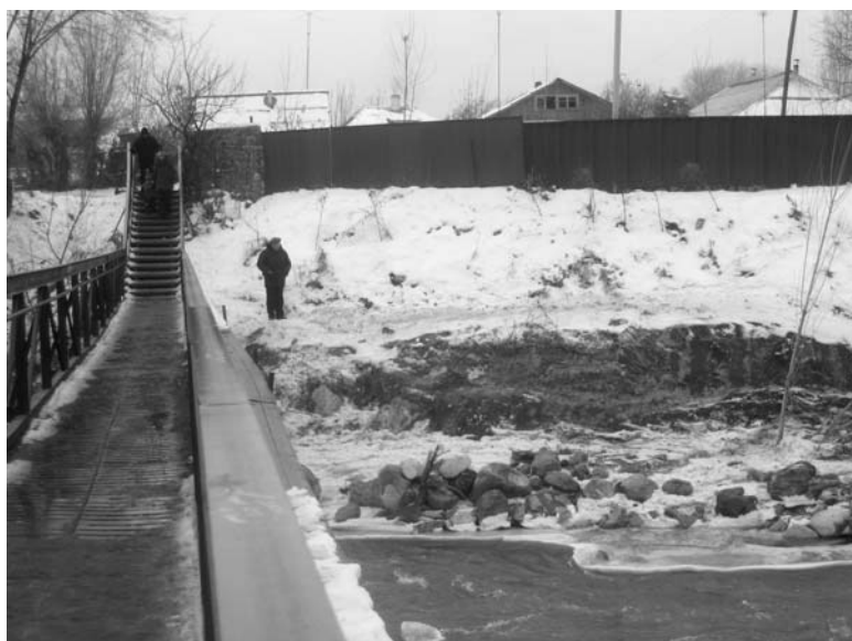
Рис. 66. Пешеходный мост в центре поселка Фабричный (длина 33 м). Человек стоит на отметке максимального уровня водоледового потока (около 5 м) (фото автора).
