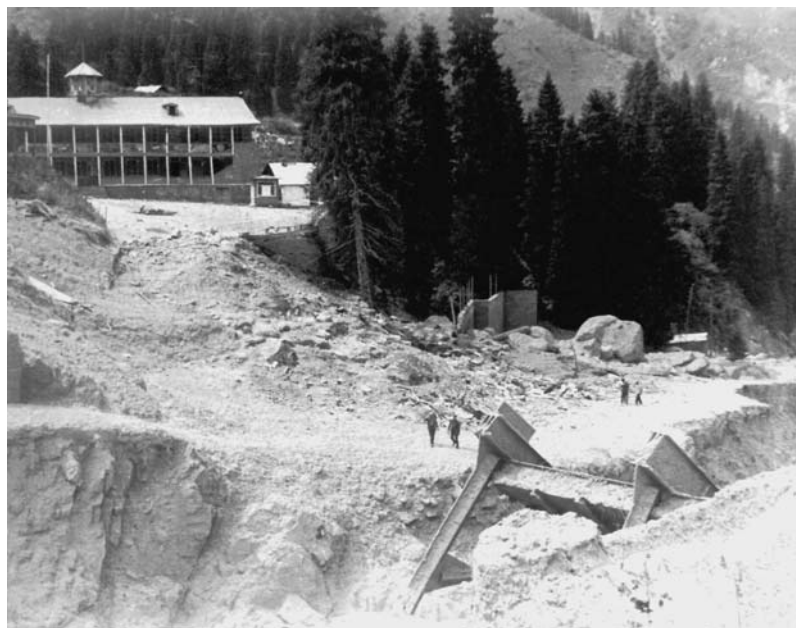
Рис. 62. Остатки сквозной плотины на р. Малая Алматинка у турбазы «Горельник».
