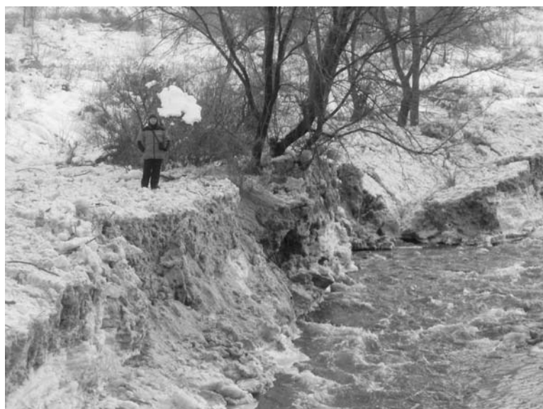
Рис. 64. Снежноледовые отложения (мощностью более 3 м) в верхнем бьефе плотины (фото автора).
