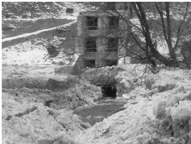
Рис. 63. Водоприемное устройство селезащитной плотины на р. Узункаргалы (вид с верхнего бьефа) (фото автора).
