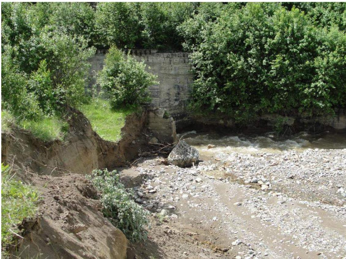
*Рис. 3. 30.05.2014 г. Разрушение левой части входного портала тоннеля 2 паводком 21.05.2014 г.*
