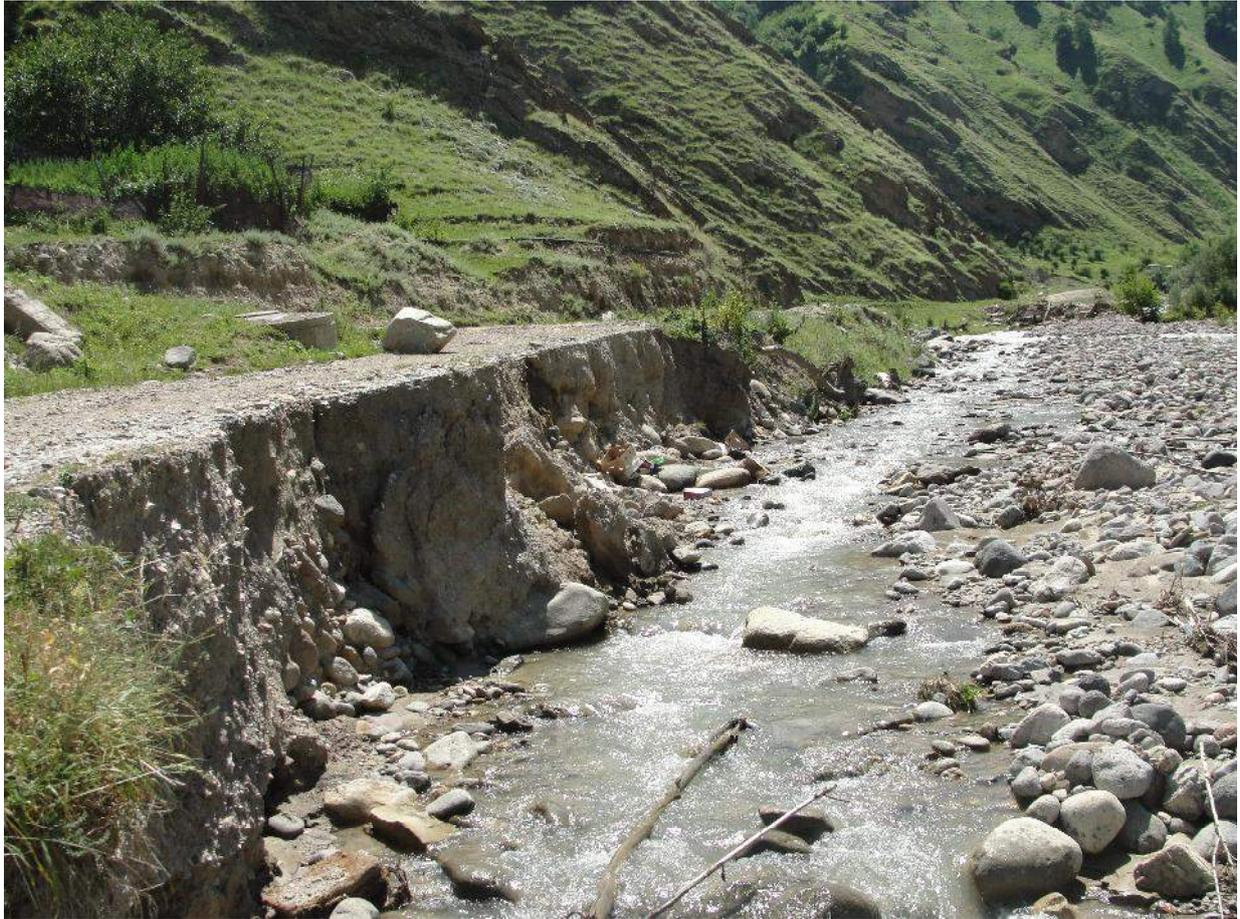
*Рис. 35. Боковая эрозия правого берега р. Гестанты водокаменным селем 21 мая 2014 г. с разрушением дороги к водозабору питьевой воды пос. Былым*
