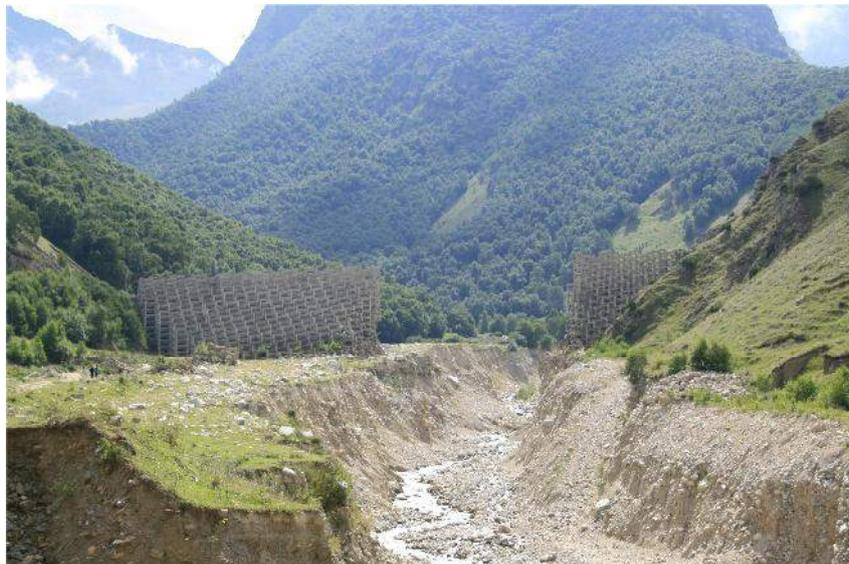
*Рис. 2. Сооружение, созданное для защиты г. Тырнауза на р. Герхожан-Суу (КБР). Разрушено селем 1999 г.*
