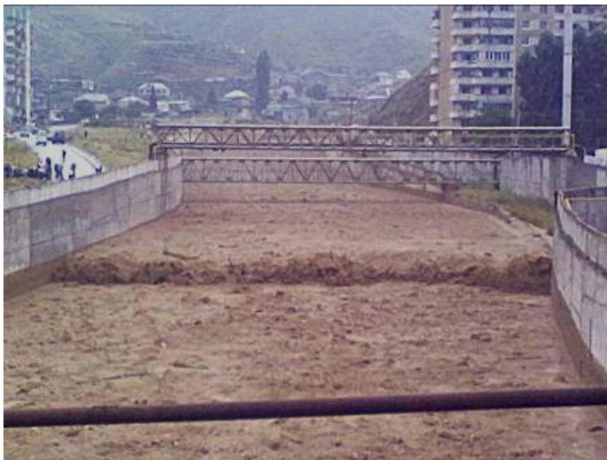
*Рис. 4. 03 августа 2011 г. Селевой поток р. Герхожан-Суу проходит по инженерному лотку в черте г. Тырнауза. Снимок М. Хаджиева*
