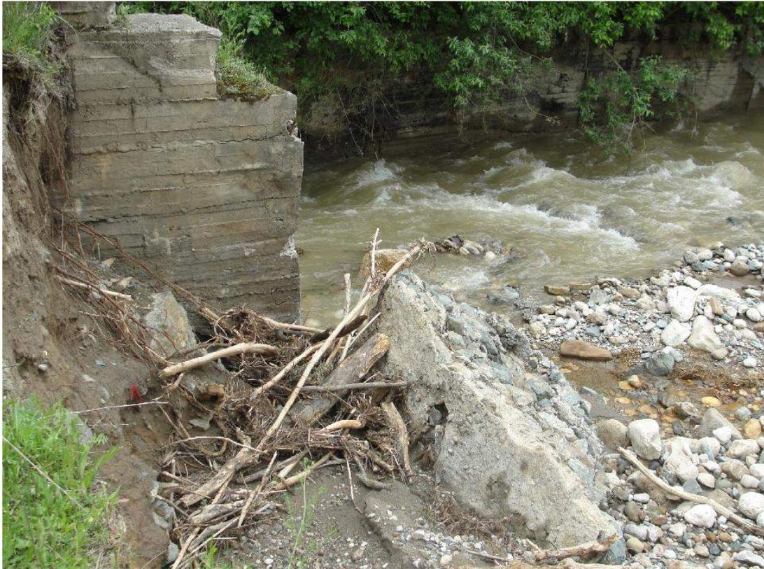
*Рис. 33. Подмыв напорного откоса и разрушение части ж/б конструкции входного портала тоннеля на р. Гижгит (КБР) при прохождении селевого паводка 21 мая 2014 г.*
