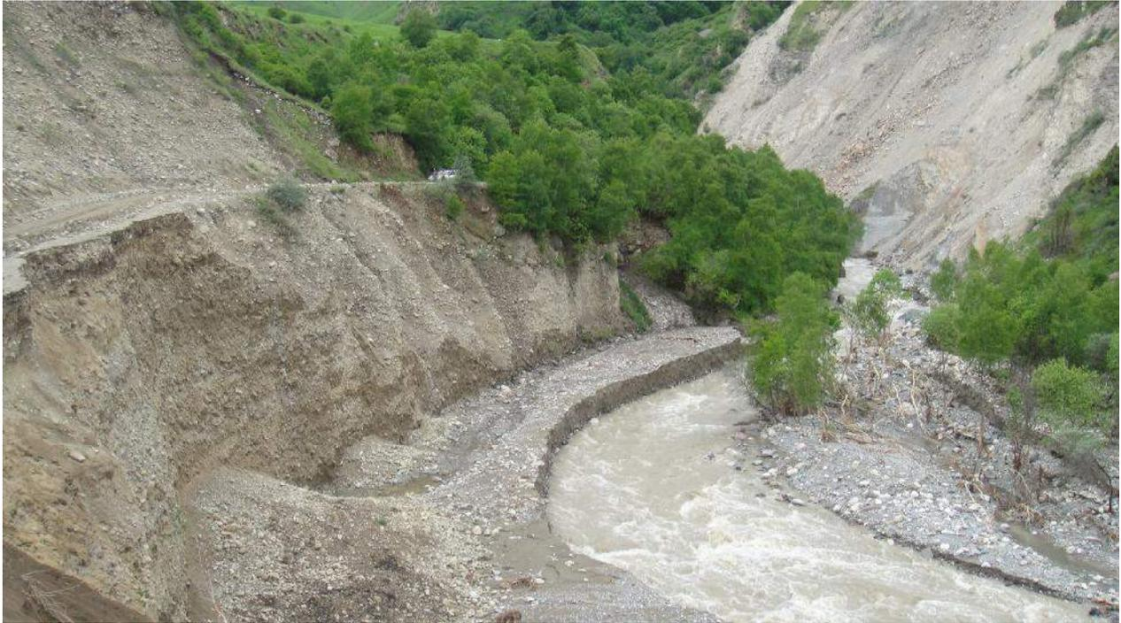
*Рис. 37. Май 2014 г. Река Чегем размывает селевые отложения, поступившие 20-21 мая 2014 г. из р. Быкмылгы-Суу (КБР). Слева разрушенный при прорыве затора участок автодороги, ведущей в верховья (пос. Эль-Тюбе, Булунгу, Турбаза, погранзастава)*
