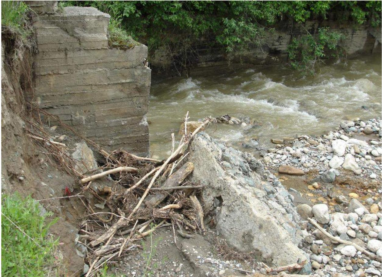
*Рис. 7. 03.06.2014 г. Подмыв откоса и разрушение части порталного входа тоннеля 2 селом 21.05.2014 г.*
