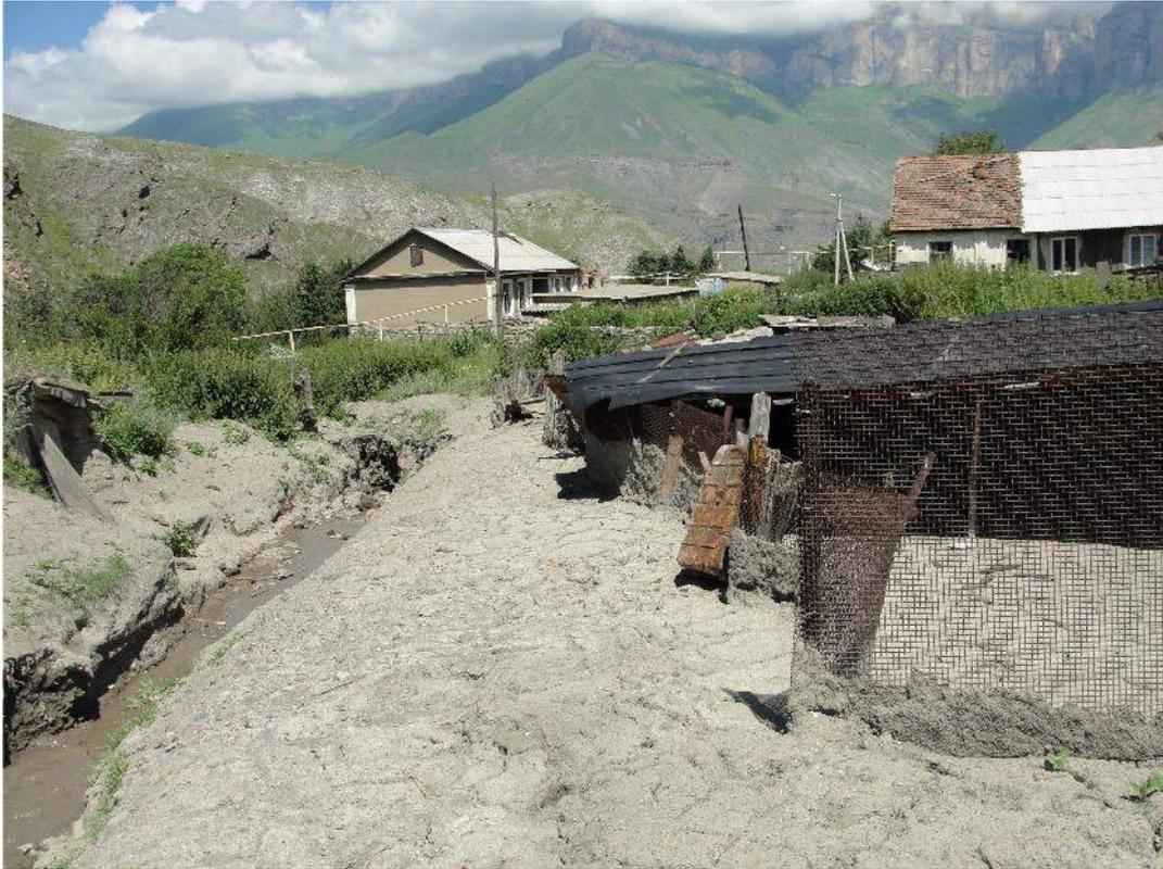
*Рис. 34. 21 мая 2014 г. Разрушение и занос отложениями грязевого селя из р. Кердеук построек пос. Былым (КБР)*
