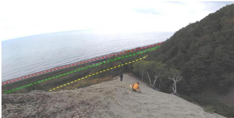
Рис. 3. Один из селевых бассейнов на участке 189-197 км автодороги Южно-Сахалинск - Оха. Желтым показано старое расположение автодороги, красным – новое, зеленым – положение железной дороги. Фото Музыченко А.А.
