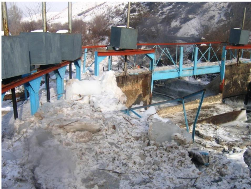
Рис. 1. Мост, разрушенный водоледовым селем в 2006 г. Фото Яфязовой Р.К., сделанное во время обследования
