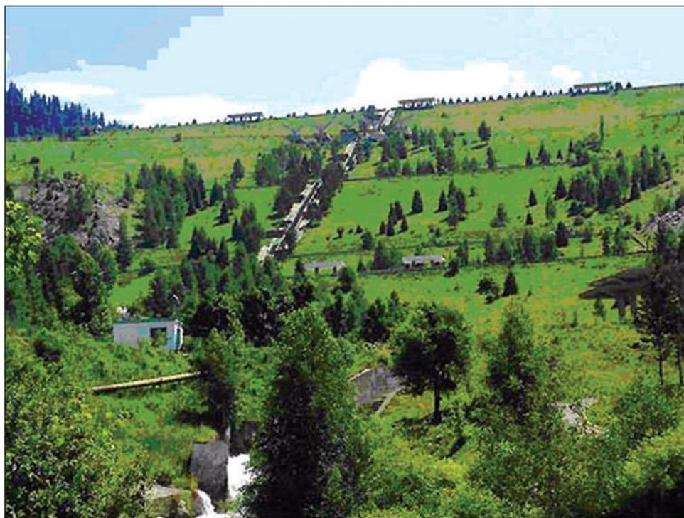
Рис. 55. Селезадерживающая плотина в ущелье Медеу (вид с нижнего бьефа)
