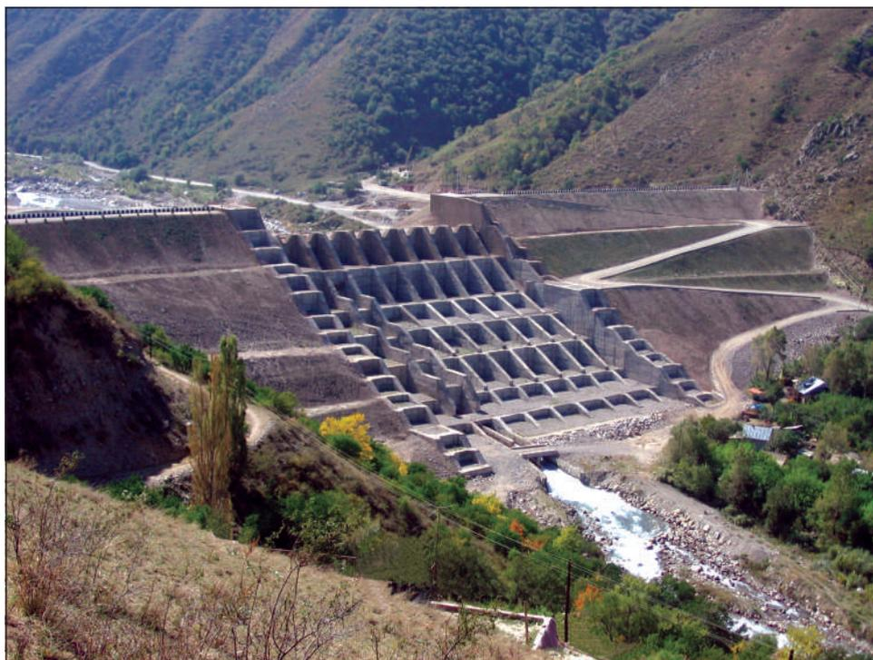
Рис. 69. Селезадерживающая плотина на р. Талгар
