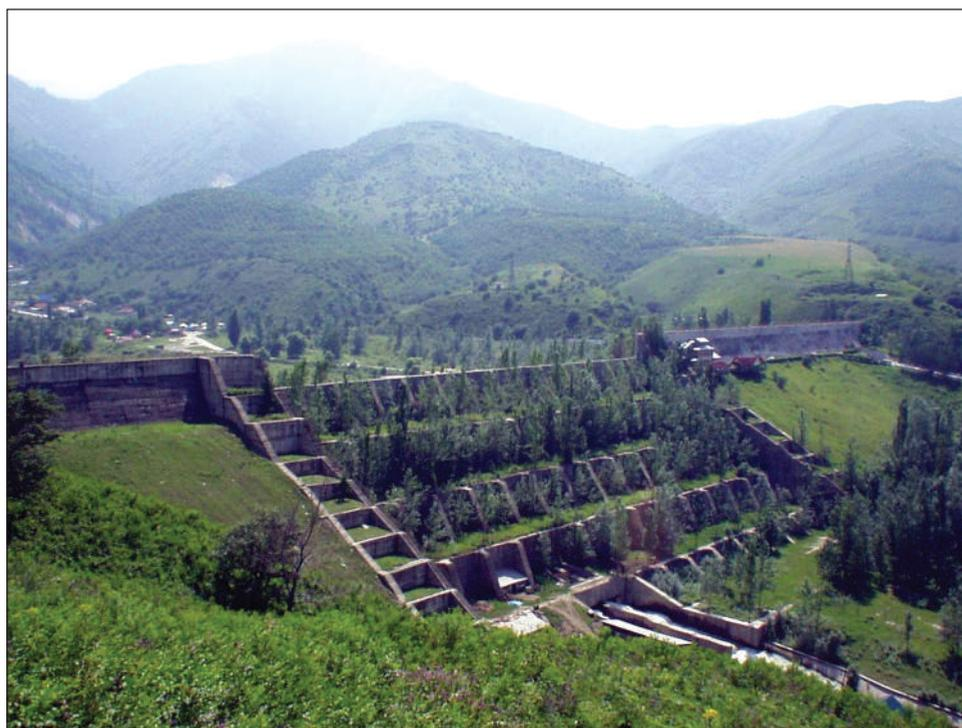
**Рис. 64.** Селезадерживающая плотина на р. Улькен Алматы (вид с нижнего бьефа)
