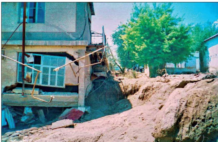
**Рис. 17.** Разрушения, нанесенные селем в пос. Казыгурт Южно-Казахстанской области
