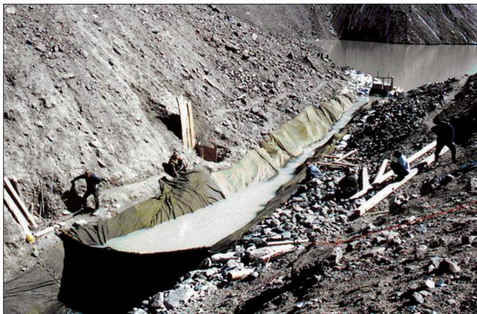
**Рис. 71.** Работы на озере №6 у ледника М. Маметовой в бассейне р. Киши Алматы по снижению прорывной опасности
