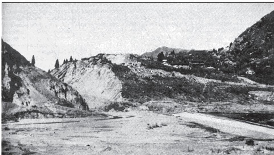
Рис. 39. Проран в перемычке оз. Есик после селя 1963 г.
