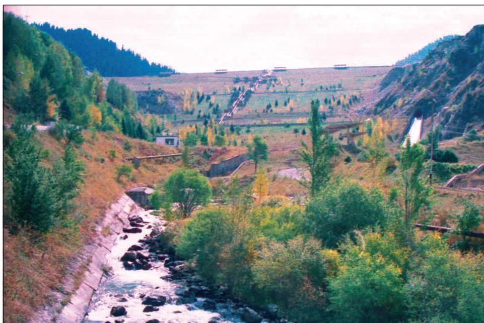
**Рис. 58.** Быстроток в нижнем бьефе плотины Медеу
