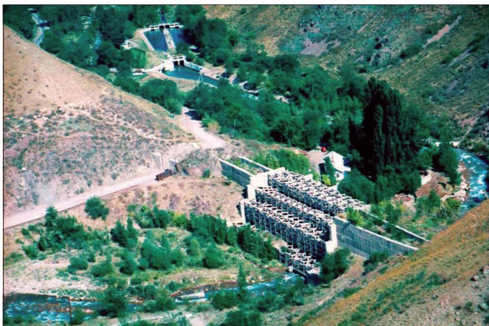
**Рис. 66.** Селезадерживающая плотина на р. Каскелен
