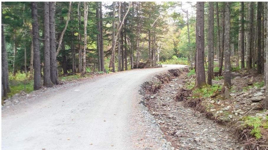
Рис. 9. Эрозионный врез по кромке дороги, образованный при переливе воды через дорожное полотно при паводках, 2019 г. Фото Л.Е. Музыченко
