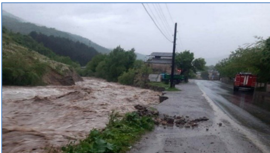
Рис. 9. Разрушенный участок дороги М6. Фото из сети «Интернет»
