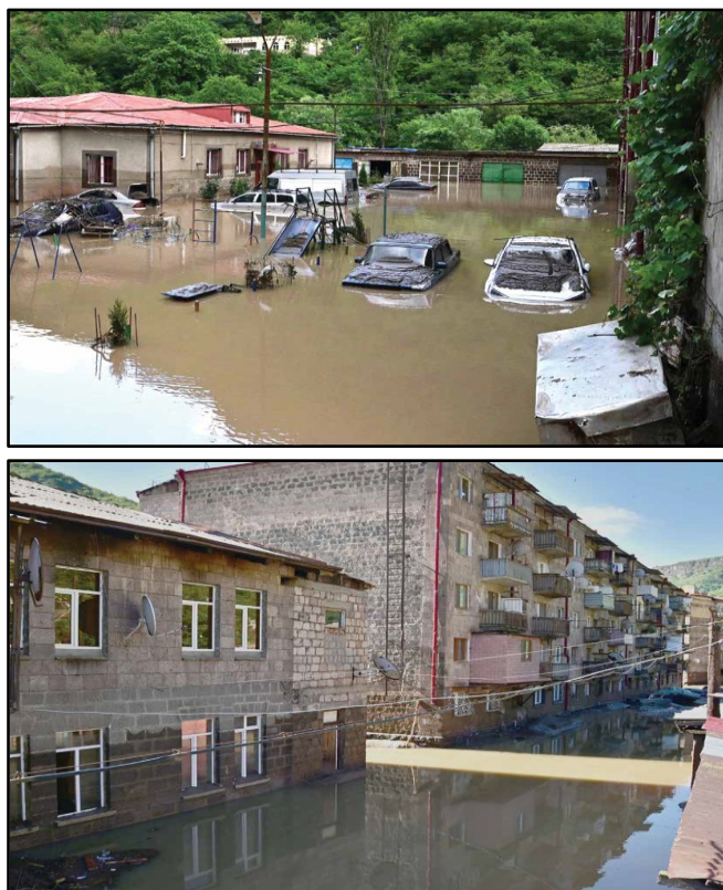
Рис. 8. Затопленные участки станции Санаин. Фото из сети «Интернет»
