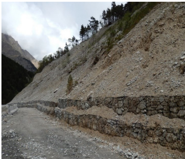
Рис. 8. Габрионная защитная стенка у подножия оползне-осыпного склона
