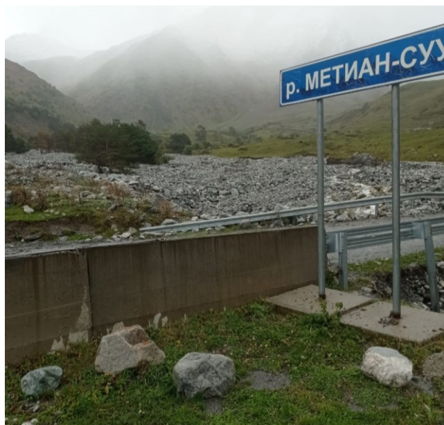
Рис. 6. Выход селевых масс ручья Ортозюрек (на дорожном знаке записан как Метиан-суу) на автодорогу
