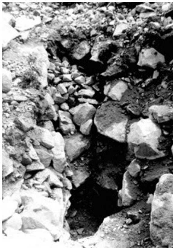
Рис. 4. Пористый каркас, вскрытый шурфом в конусе выноса рывтины. Фото А.Х. Хайдарова
