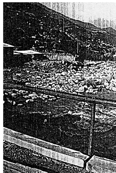
**Рис. 11. Разрушительные последствия прохождения селя на притоке р. Цхенисцкали Хеледула. Видны следы перелива потока через мост. 17 августа 1983 г. (фото ЗакНИГМИ)**
