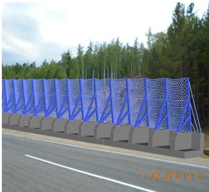
Рис. 7. Общий вид расположения селеудерживающих барьеров на местности
