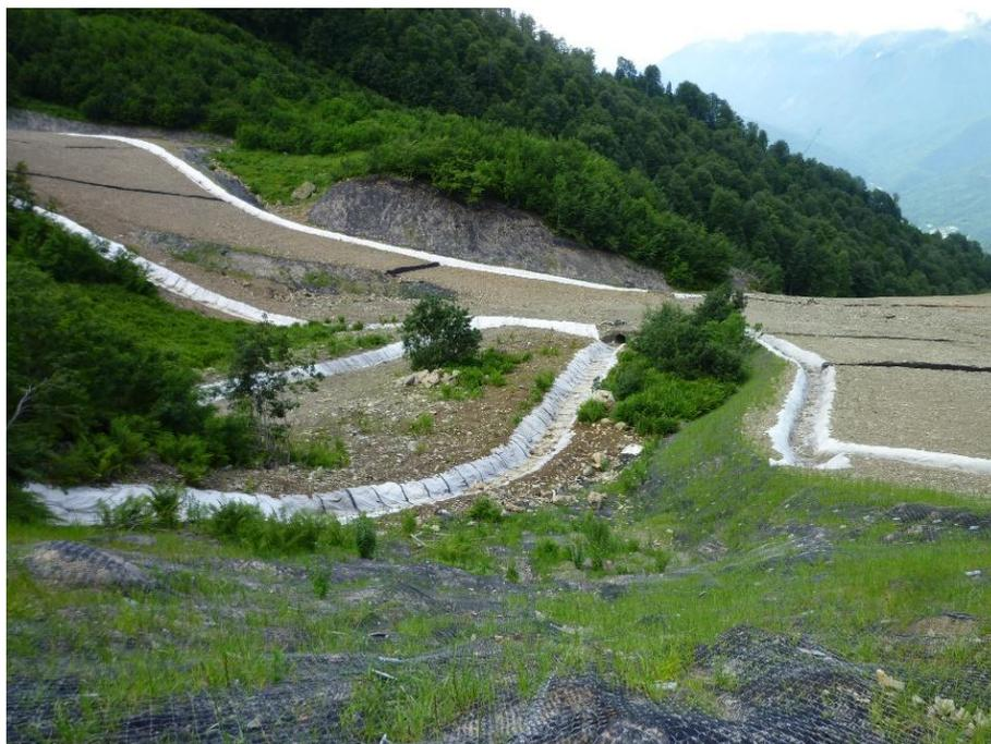
Рис. 8. Пример противозерозивной защиты. Фото Л.М. Дзаганиа
